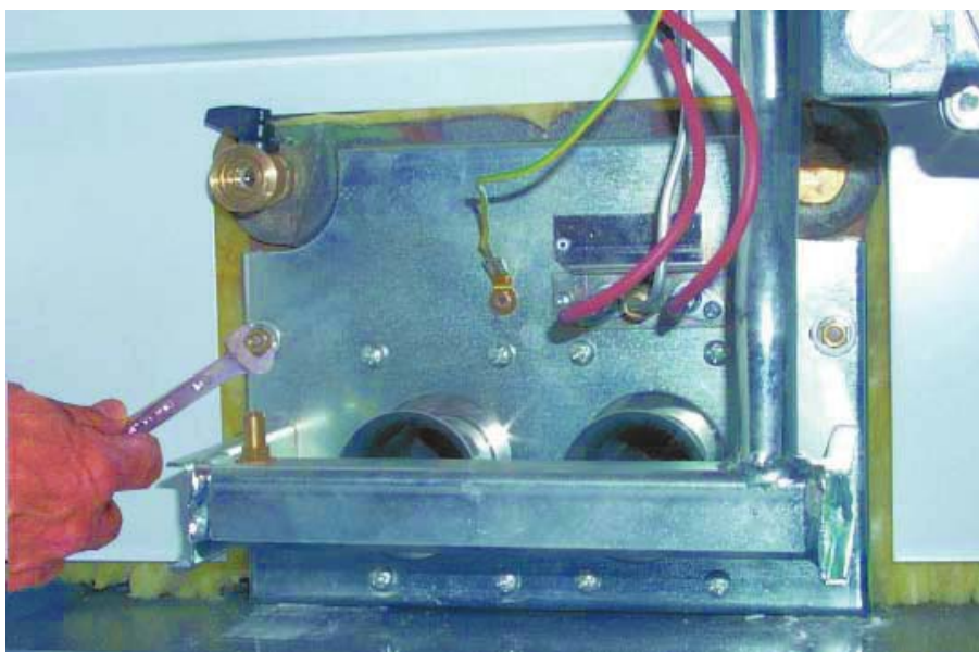
рис. 21 - Демонтаж горелок
